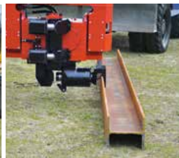
Управление, захват и забивка двутавра
