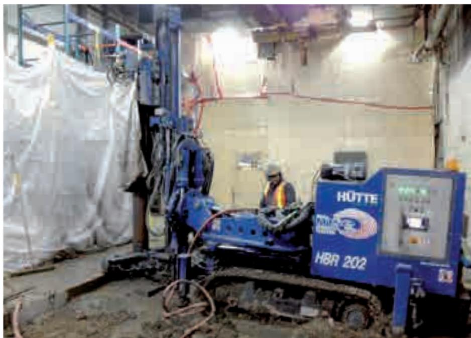
Благодаря работе на электродвигателе не возникает выхлопных газов
