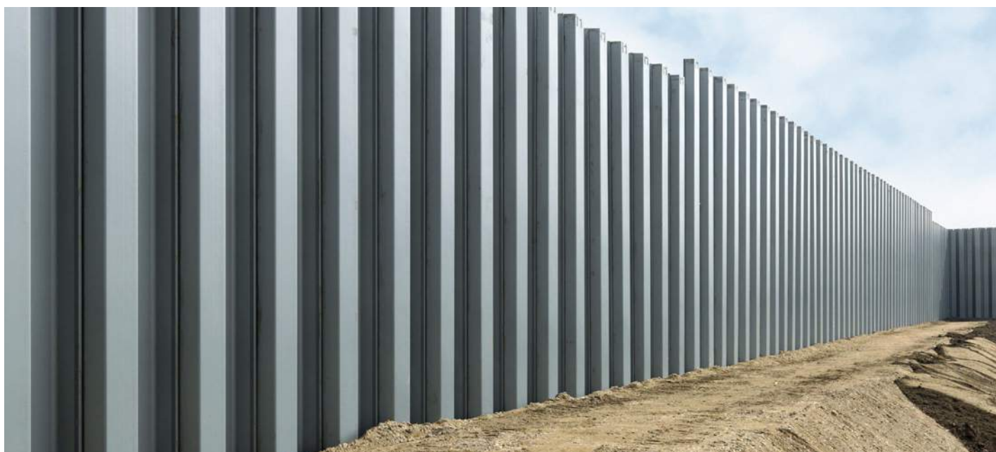
Опорная шпунтовая стенка с защитным покрытием и уплотнением, Эссен
